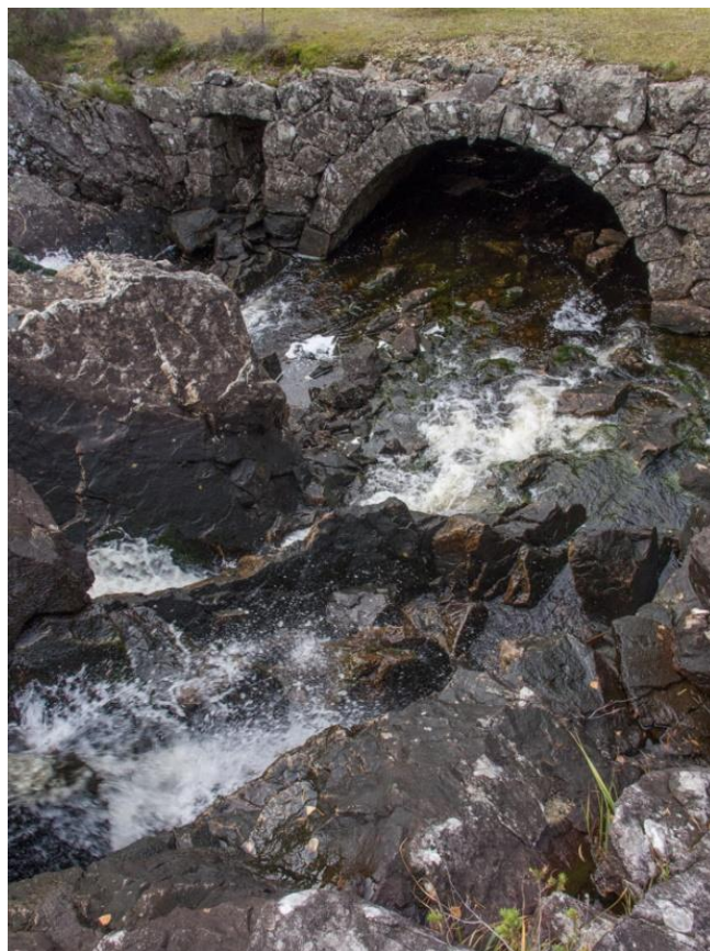
Figur 7 Bru under Fitjarvegen ovanfor Dåfjorden. Foto: Multiconsult
