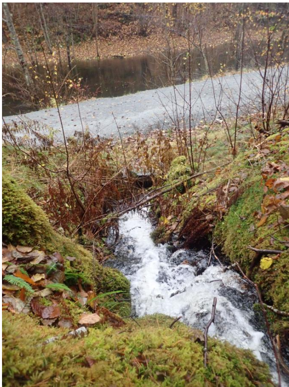
Figur 5 Røyr under turvegen langs Frugardselva. Foto: Multiconsult
