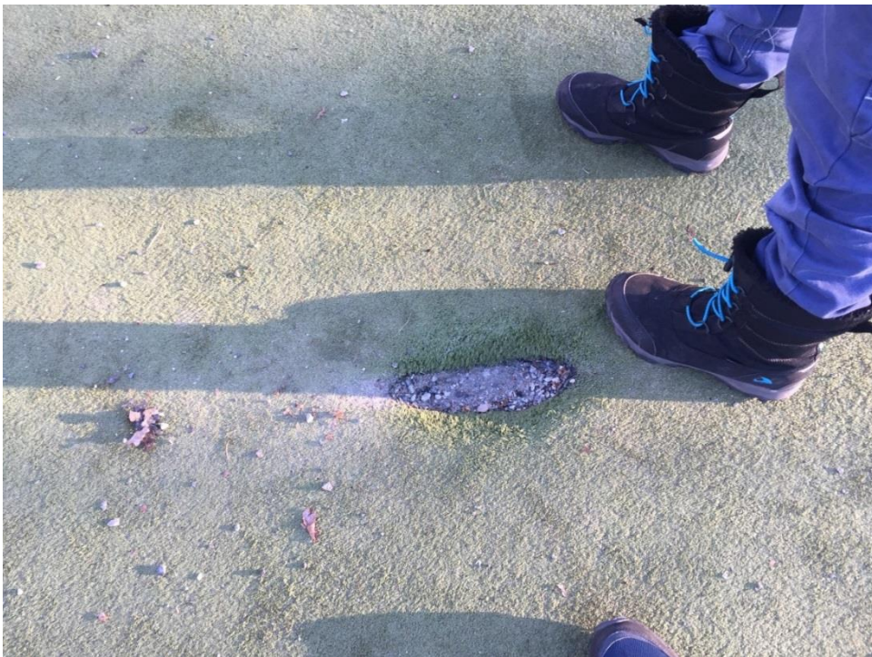
Foto: Skade på dekket/underlaget
