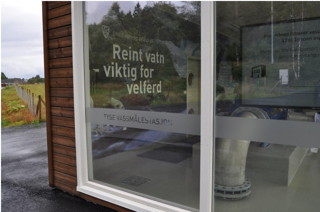
Figur 14 Tyse vassmålarstasjon: Moderne vassmålarstasjon med informasjonstavle og vindauge.
