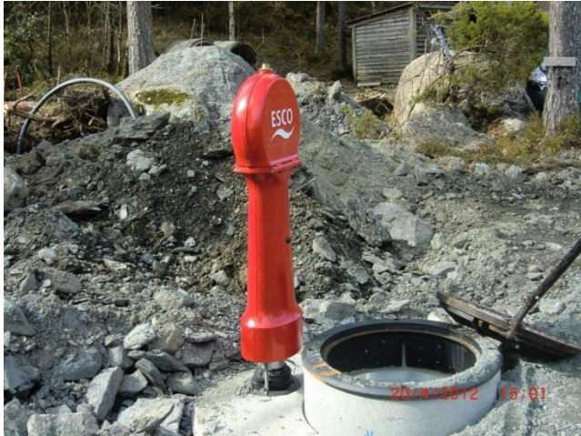
Figur 13 Eldre og dårlig drenert vasskum oppe t.v. Utsetting av ny vasskum oppe t.h. Ny brannhydrant nede t.v. og ny vassleidning nede t.h.
