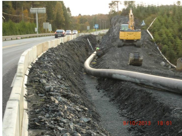
Figur 13 Eldre og dårlig drenert vasskum oppe t.v. Utsetting av ny vasskum oppe t.h. Ny brannhydrant nede t.v. og ny vassleidning nede t.h.
