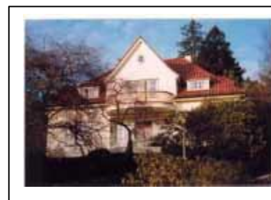
Valmtak med teglpanner
