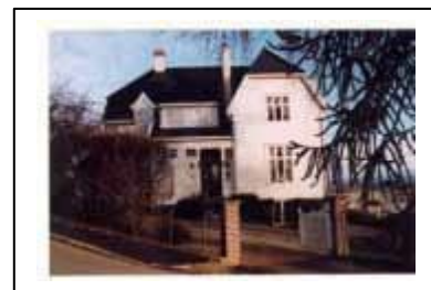
Halvvalm med teglpanner
