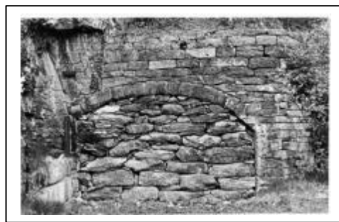
Opning i natursteinsmur
