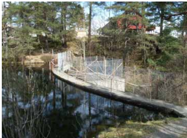
Figur 5 Det gamle vassverket i Lønningsåsen
