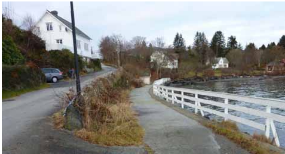
Figur 8 Gangveg ved Klingenbergkaien
