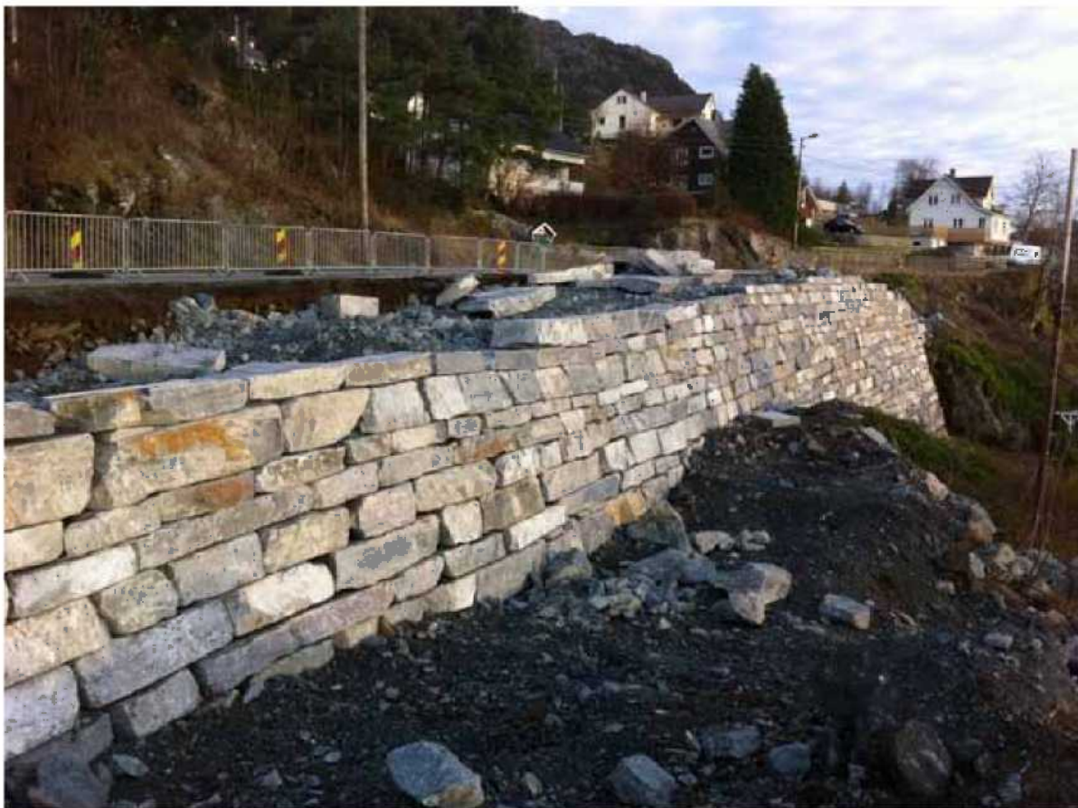
Hausten 2011 starta arbeidet med utbetring av både veg, vass- og avlaupsnett på Jensanesvegen. Området skal etter planen vera ferdig utbetra i august 2013. (foto: Øyvind Dahl)
