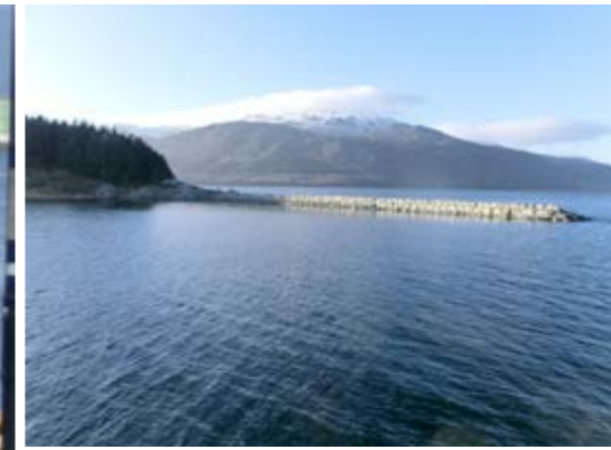
Arbeidet med molo på Nordhuglo vart sett i gang i 2012. (Foto: Stordnytt.no)
